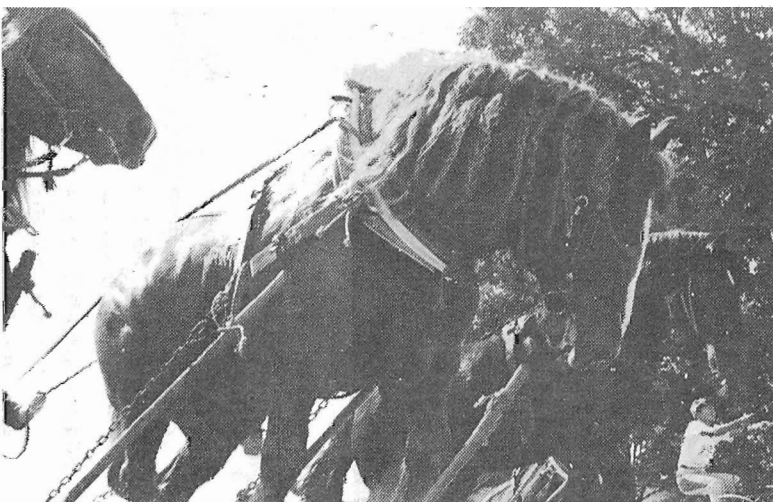
全力出して！第2障害上（足寄町）
